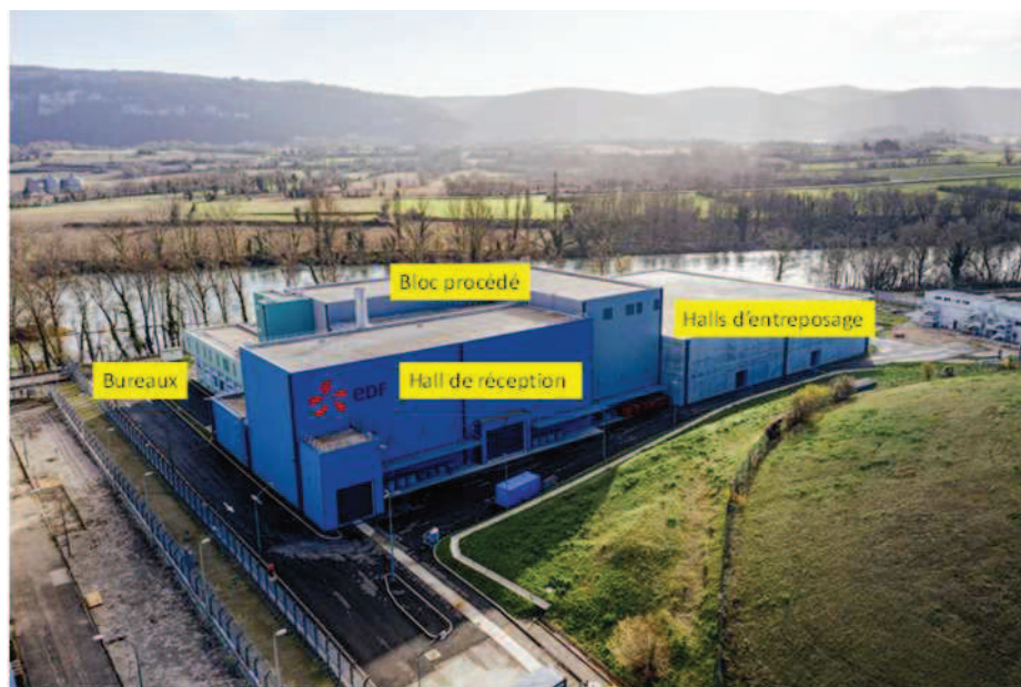
Figure 2.f : Photographies de l'ICEDA et implantation des principaux bâtiments © EDF – Romain DELANEZ
